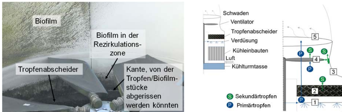
Abbildung 2 Tropfenemission aus unterschiedlichen Quellbereichen am Auslass einer Kühlzelle mit saugend angeordnetem Ventilator
