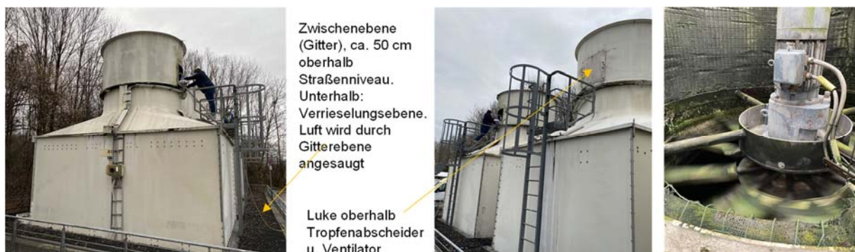
Abbildung 62: Verdunstungskühlanlage Garching
