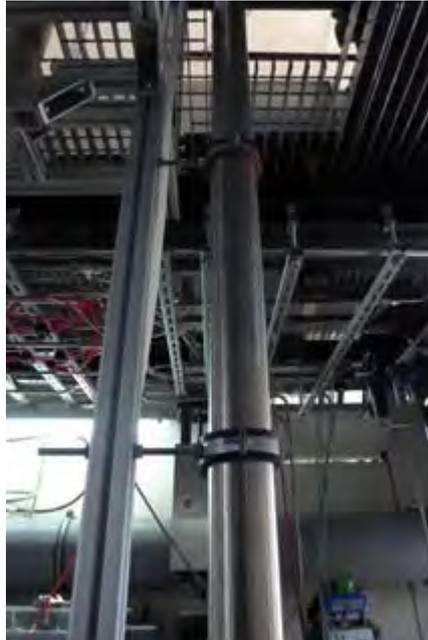
Abbildung 1.10: Aufhängung des Abgasrohres mit Schlauchschellen
