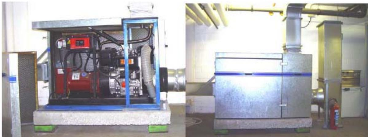
Abb. 3.42 Notstromaggregat mit Dieselmotor (offen und geschlossen)
