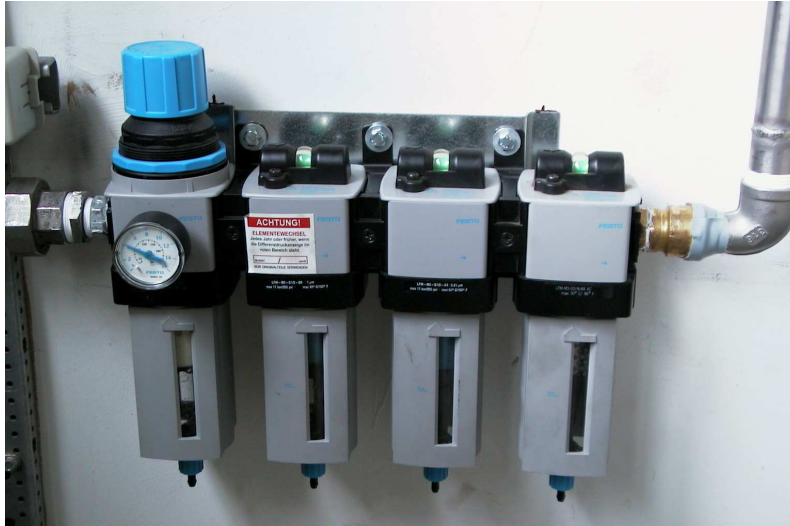
Abbildung 32 Filtereinheit zur Entfernung vorhandener Partikel in der Druckluft
