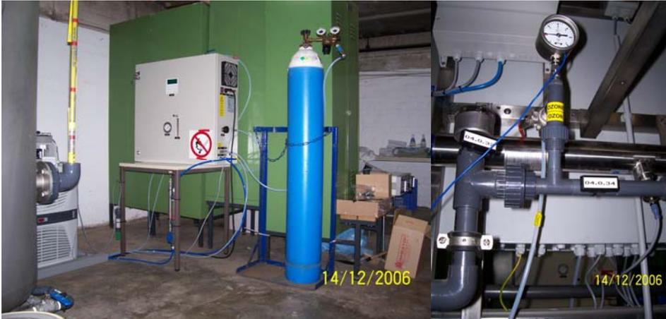
Abbildung 5.6: Foto der von der Fa. WEDECO zur Verfügung gestellten Ozonanlage (links) und des Ozon-Unterdruck-Injektors (rechts)
