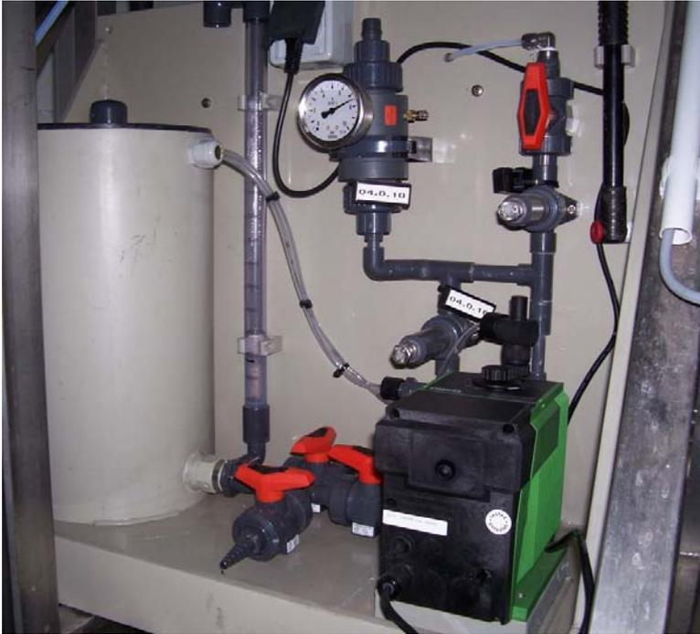
Abbildung 5.4: Foto der Wasserstoffperoxid-Dosiervorrichtung
