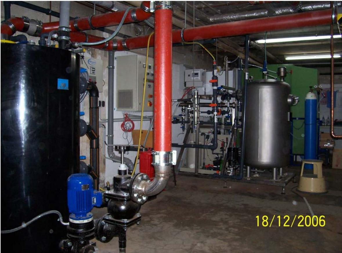
Abbildung 5.7: Foto der gesamten Demonstrationsanlage mit den Anschlussleitungen an das Toilettenabwassersystem im IUTA.
