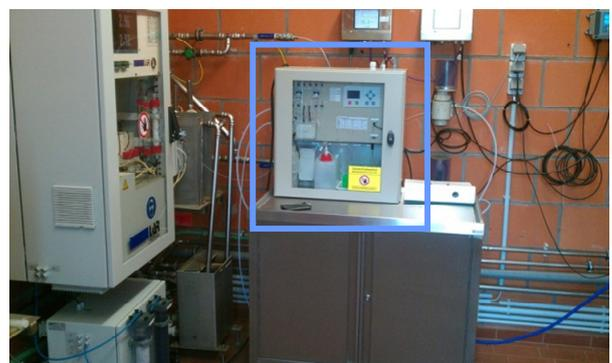
Bild 3-12: Ozonung der Kläranlage Duisburg – Vierlinden (oben) und Installation des vor-Ort Messgerätes EstraMonitor zur Bestimmung östrogenen Effekte (unten)
