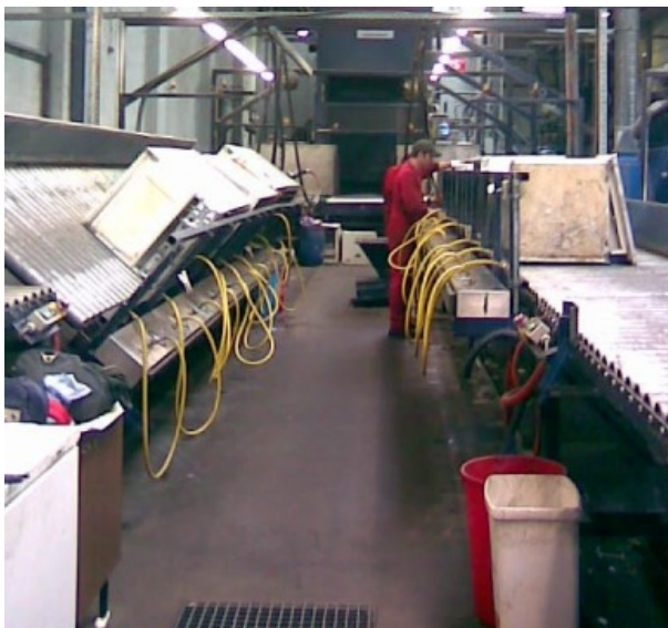
Bild 4-75: Trockenlegung des Kältekreislaufs in Stufe 1
