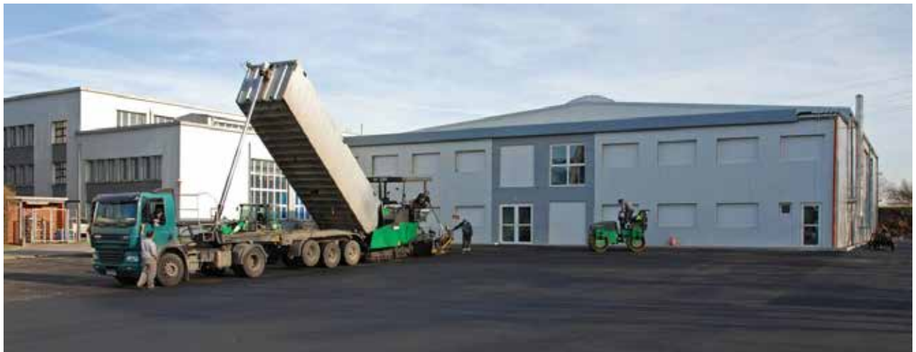
Bild 4-9: Neubau mit Technikumshalle und Bürokomplex
