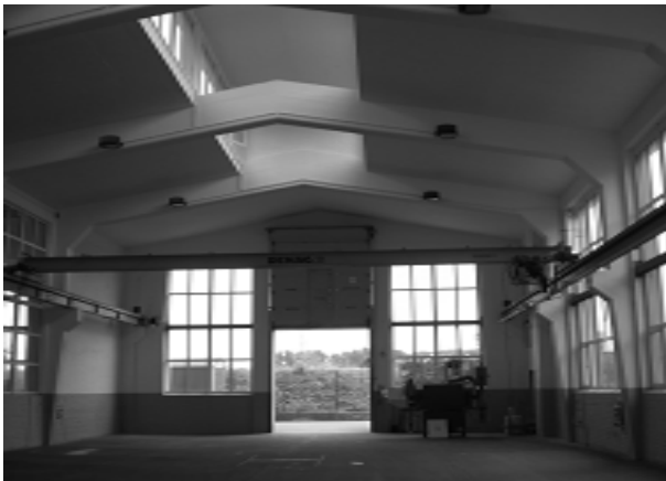
Bild 4-84: Die sanierte Zerlegehalle
